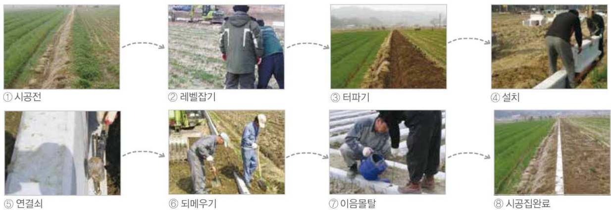
그림 A.3 — 두렁블록 시공순서(예시)
